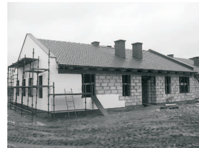
Budynek socjalny w trakcie budowy (fot. R. Ebertowski)
